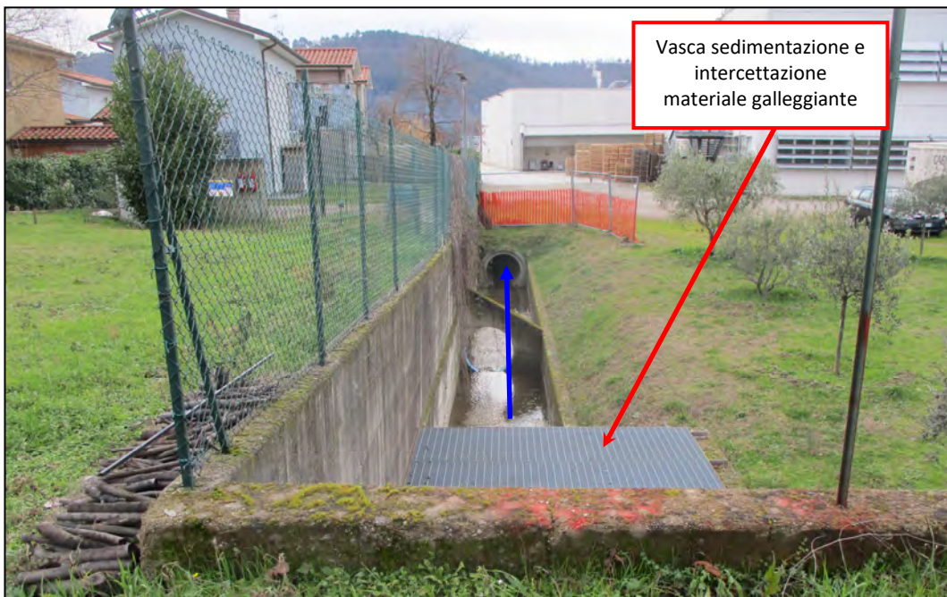
Foto 26. M-Mercato – Tratto a valle della ferrovia.
