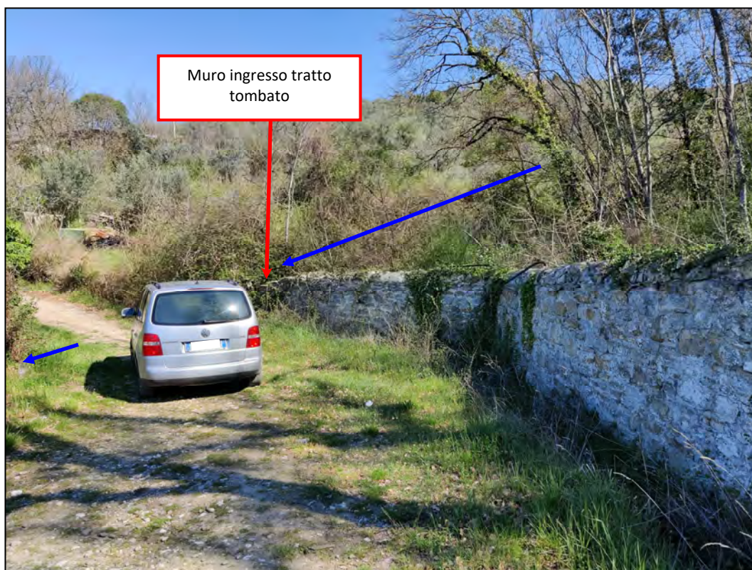
Foto 23. M-Mercato – Muretto di monte, in corrispondenza dell'inizio del tratto tombato.
