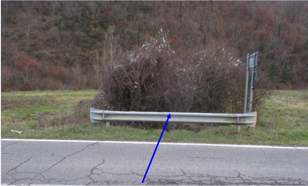
Foto 36. Q-Aff. Chiassa –Attraversamento Strada Provinciale della Libbia.
