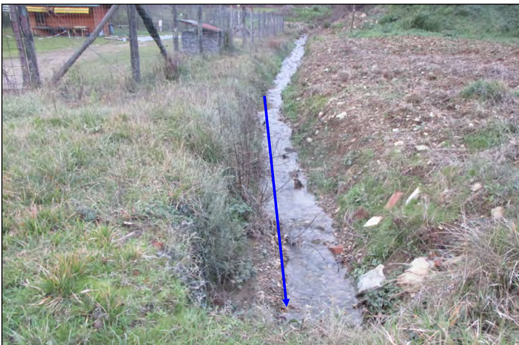
Foto 35. Q-Aff. Chiassa –tratto a monte dell'attraversamento Strada Provinciale della Libbia.
