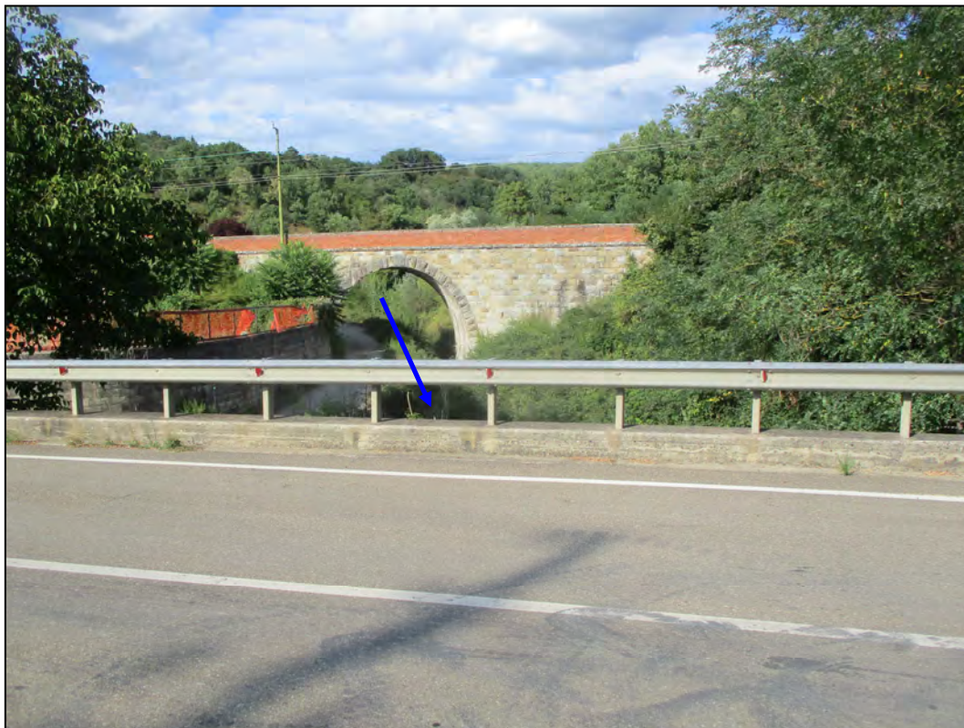
Foto 2. B-Brelle – Tratto a monte dell'attraversamento stradale.
