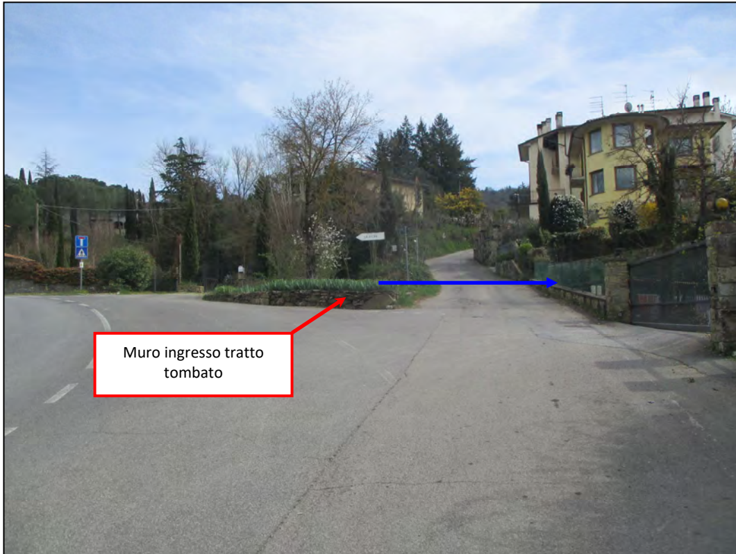
Foto 14. H-La Vigna – Vista muretto ingresso tratto tombato.
