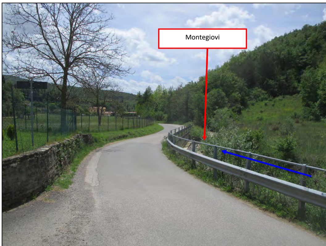
Foto 29. N-Montegiovi – Tratto di monte.
