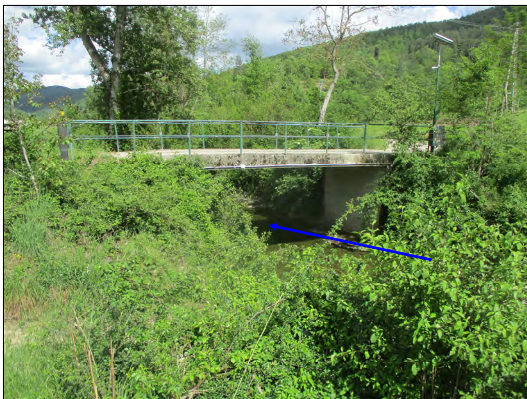
Foto 41. S-Chiassa – Attraversamento Strada loc. I Pianelli.
