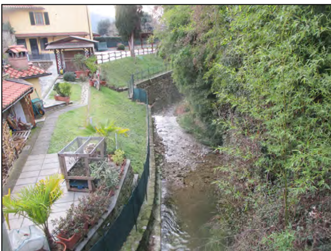
Foto 12. G-Bagno - a valle dell'attraversamento via Aretina.
